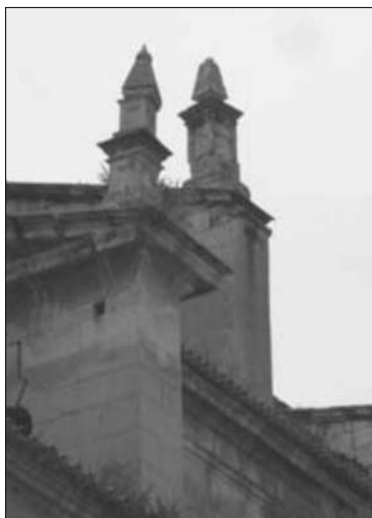
FIGURAS 12 y 13: A la izquierda, elementos de remate de coronación (pináculos) de la iglesia de San Patricio, que han registrado giros e incluso derrumbes, por pérdida de equilibrio ante la acción horizontal de sismo. A la derecha torre-campanario del convento de las Clarisas, fracturado por las zonas del menor resistencia a cortante de la fábrica.
