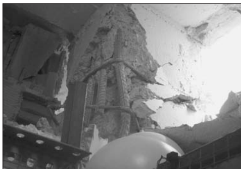
FIGURAS 18 y 19: A la izquierda, daños en la estructura: pilar de un sótano, degollado en su cabeza por la acción sísmica. A la derecha, detalle de otro pilar con el mismo efecto, en el que se observó un déficit de cercos.
