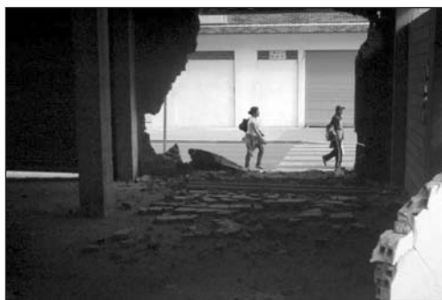
FIGURAS 24 y 25: Obsérvese en las plantas bajas el daño generalizado de los cerramientos, mientras las estructuras de los edificios permanecieron en pie.
