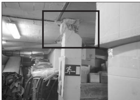
FIGURAS 18 y 19: A la izquierda, daños en la estructura: pilar de un sótano, degollado en su cabeza por la acción sísmica. A la derecha, detalle de otro pilar con el mismo efecto, en el que se observó un déficit de cercos.
