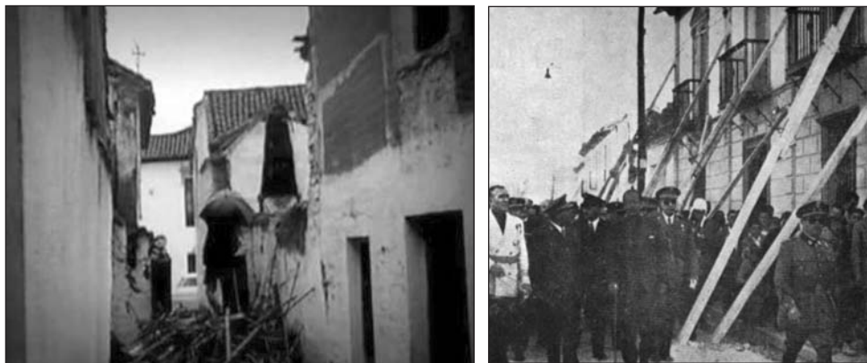
FIGURAS 1 y 2. Daños del terremoto de Albolote (1956), que afectó a un pueblo con construcciones de muros de fábrica de mampostería de piedra y tapial, de una y dos plantas de altura. Fuente: NO-DO.
