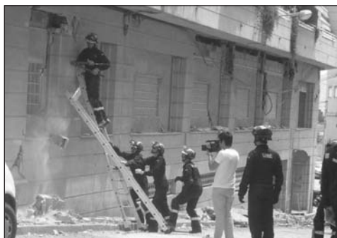
FIGURAS 30 y 31: A la izquierda, daños en los cerramientos, especialmente en las plantas bajas. A la derecha, grietas en aspa, en las tabiquerías interiores de ladrillo.
