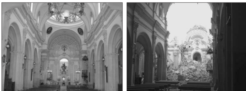
FIGURAS 10 y 11: Iglesia de Santiago fotografiada antes y después del terremoto. Se hundió la parte más rígida de la estructura de cubierta: el crucero con el cimborrio.
