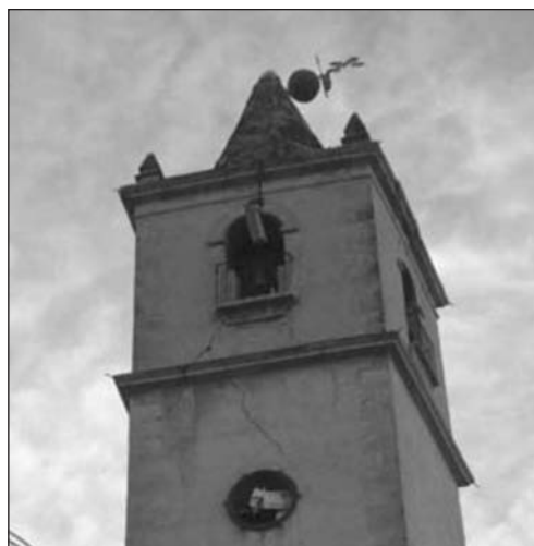
FIGURAS 14 y 15: Torre de la iglesia de Santiago y torre de la iglesia del Paso Azul, con daños por esfuerzo cortante en las fábricas, en las zonas más débiles (de huecos).
