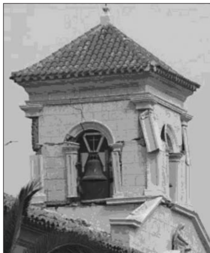
FIGURAS 12 y 13: A la izquierda, elementos de remate de coronación (pináculos) de la iglesia de San Patricio, que han registrado giros e incluso derrumbes, por pérdida de equilibrio ante la acción horizontal de sismo. A la derecha torre-campanario del convento de las Clarisas, fracturado por las zonas del menor resistencia a cortante de la fábrica.
