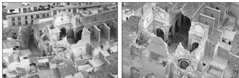
FIGURAS 8 y 9: Iglesia de Santiago cuyo crucero resultó completamente derrumbado por el sismo. Imágenes aéreas tras el terremoto.
