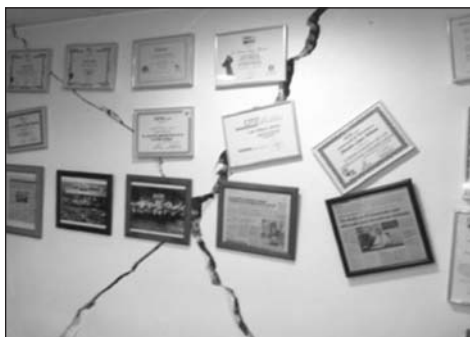
FIGURAS 30 y 31: A la izquierda, daños en los cerramientos, especialmente en las plantas bajas. A la derecha, grietas en aspa, en las tabiquerías interiores de ladrillo.
