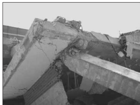
FIGURAS 20 y 21: A la izquierda, pilar corto, destruido por el sismo; este tipo de pilares, por su imposibilidad de oscilar, es el que resulta más afectado. A la derecha, rotura por la cabeza de un pilar, del edificio que colapsó completamente.
