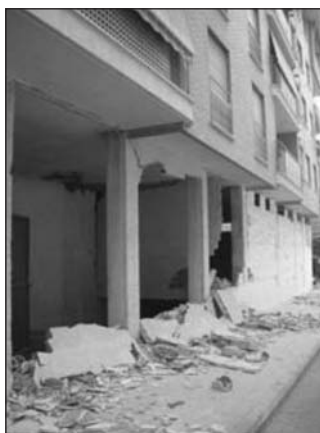
FIGURAS 28 y 29: A la izquierda, un ejemplo de edificio con cerramiento de ladrillo, sólo parcialmente apoyado en el borde del forjado. La estructura ha permanecido en pie cumpliendo las exigencias de la norma sísmica, pero los cerramientos se han derrumbado produciendo enormes daños materiales y riesgo de daños personales. A la derecha, un edificio en el que tanto estructura como cerramientos convencionales se comportaron correctamente, y lo que se derrumbó fue el «cerramiento provisional» con el que se tabicó los locales comerciales para su venta.
