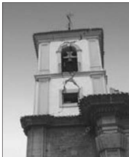
FIGURAS 14 y 15: Torre de la iglesia de Santiago y torre de la iglesia del Paso Azul, con daños por esfuerzo cortante en las fábricas, en las zonas más débiles (de huecos).
