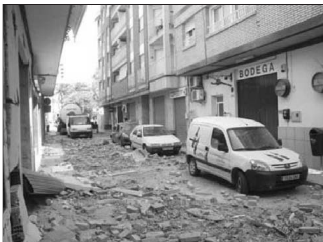
FIGURA 32: Fotografía de la calle Galicia, en la que se produjeron varios de los fallecidos. Obsérvese cómo quedó la calle con los fragmentos de cerramientos caídos de los edificios.
